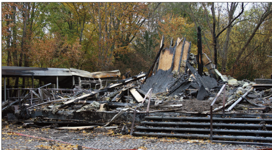
Nur noch Schutt und Asche blieben nach dem Brandanschlag vom Freilandlabor übrig, auch ein Infopavillon (im Hintergrund links) brannte aus. Fotos: Bothe
